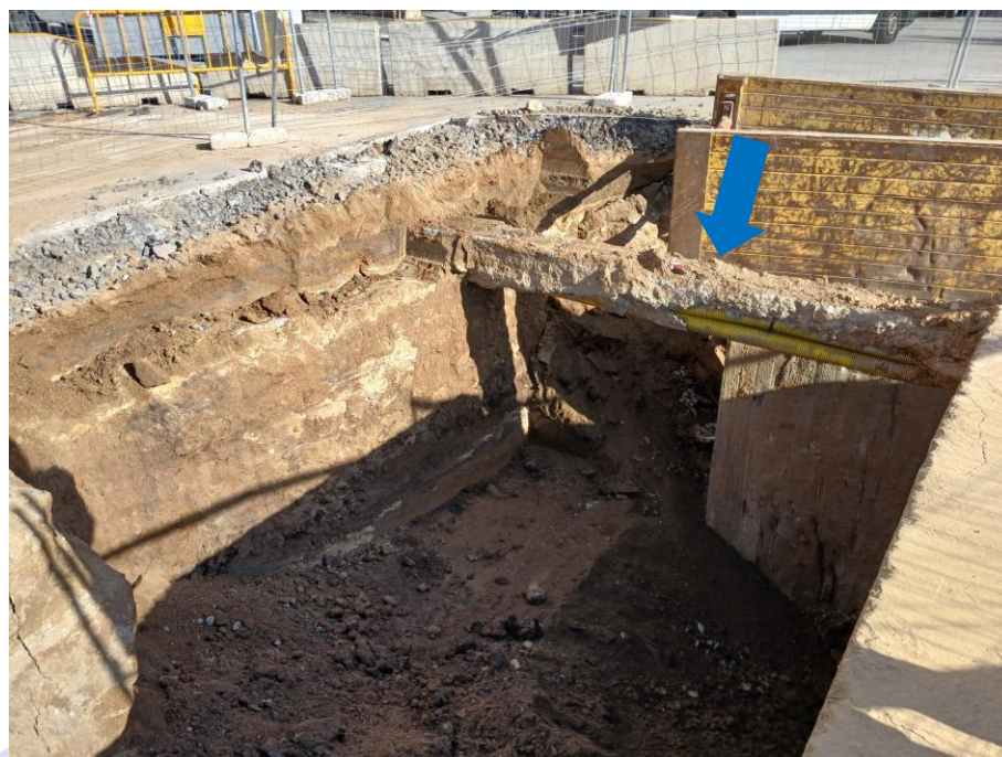
Canalització fibra òptica
