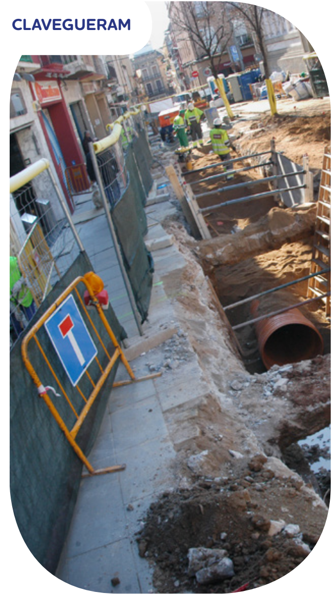
Plaça de Cuba i carrer de Palmerola Renovació de la xarxa de clavegueram i substitució de les llambordes Inici febrer 2016 • Durada 12 setmanes
